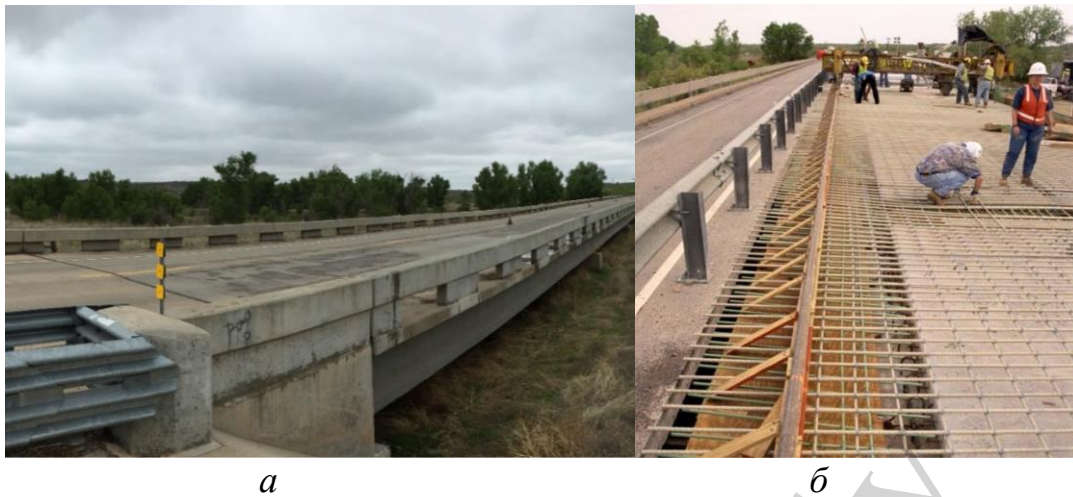
Рис. 5. Міст «Sierrita dela Cruz Creek», Амарілло, Техас: а – загальний вигляд станом на 2015 рік; б – влаштування композитного армування дорожнього покриття [20]
